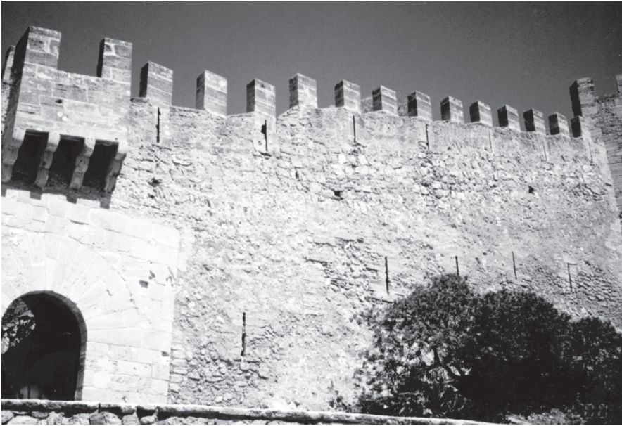
Llenç de la tanca, vora del Portalet, amb una filera de sis espitlleres que defensen el camí d'accés. Una de les espitlleres, la de més a la dreta, va quedar quasi absorbida per la torre d'en Banyà. (Foto: Pau Cateura.)
