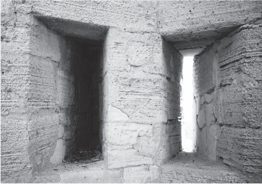
Doble espitllera, una d'elles aparemada per l'adossament d'una torre. (Foto: Pau Cateura.)
