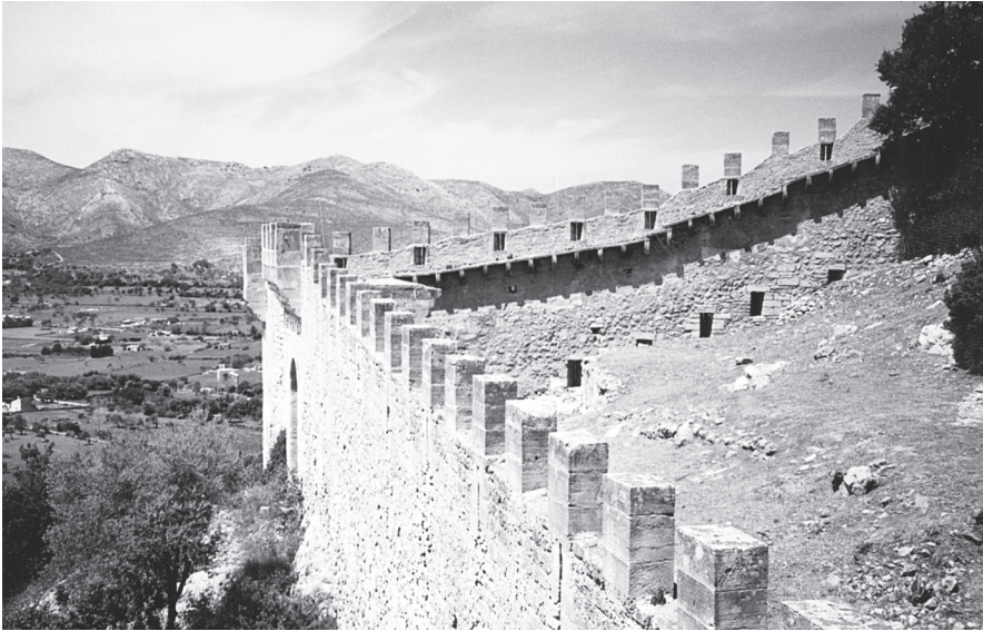
Llenç del Sud del recinte. A la fotografia queda ben visible el corriment de terres que ha arribat a encegar les espitlleres que es veuen al fons. (Foto: Pau Cateura.)
