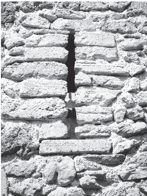
Espitllera vora la porta del rei en Jaume construïda en petits blocs de marès. (Foto: Pau Cateura.)
